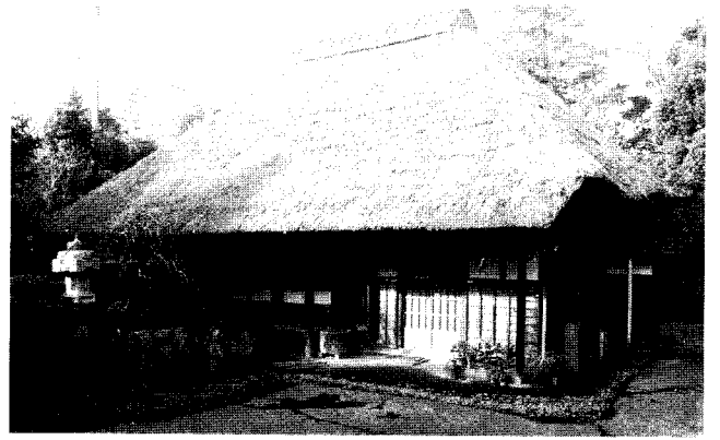
小泉家主屋（解体前）
